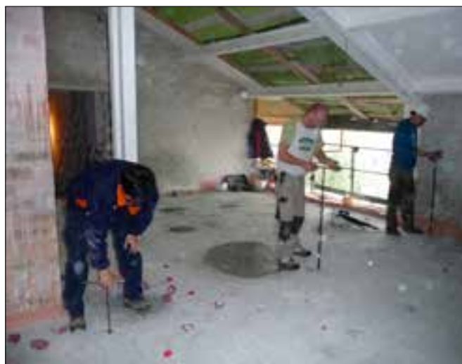
Instalación soporte FZH+Sylomer®.
