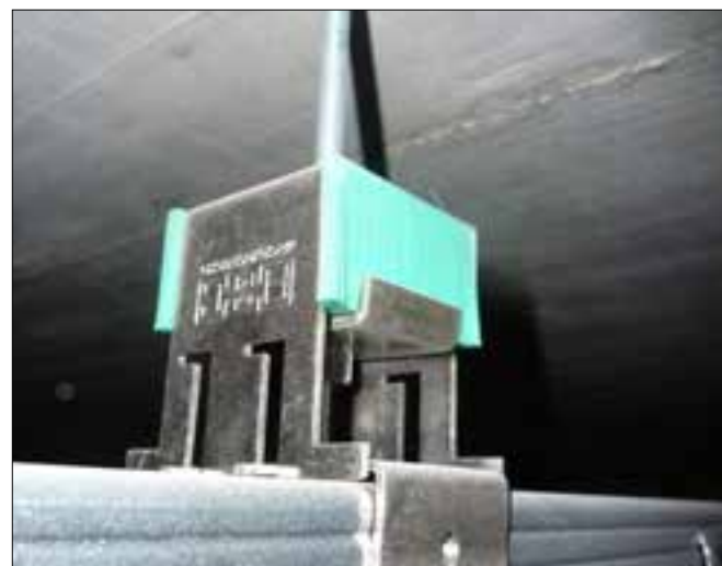
Akustik Super T60 + Sylomer 30 Type B en estudios de grabación HIGAIN USURBIL.
